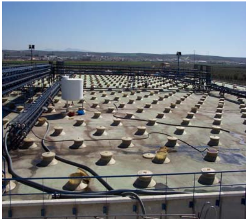
Figure 23.- Patio de fermentadores enterrados
