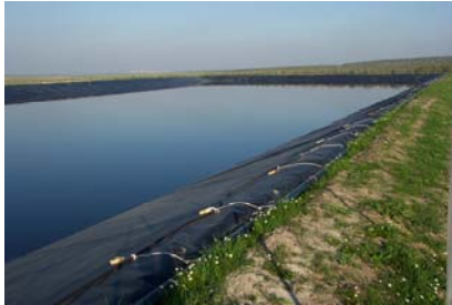
Figura 18.- Balsa de evaporación de alpechín
