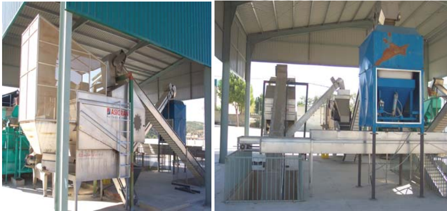
Figura 2.- Instalación para el lavado y pesado de la aceituna
