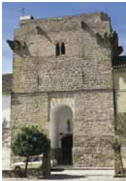
TORRE DEL CASTILLO DE CAÑETE
