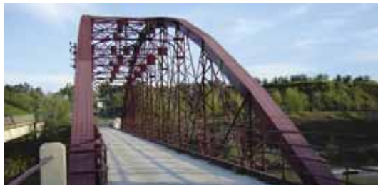
PUENTE DE HIERRO
