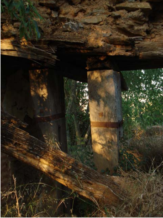
Fig. 2 Restos del molino de la Cartuja de Cazalla, Sevilla. Foto: Bernardo Gómez Delgado.
